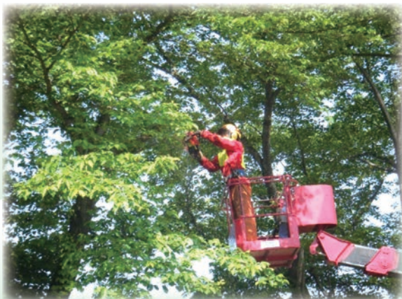
支障木の伐採
