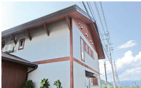
ガルバリウム鋼板の外壁
