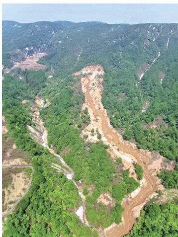
写真1 飯山市井出川の山腹崩壊の状況
