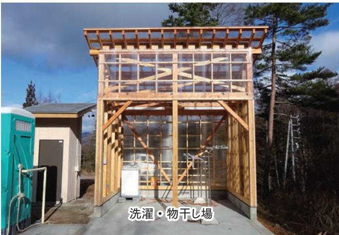
屋根が完成した給油所
