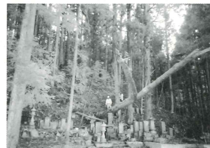
架線による被害木の撤去作業
